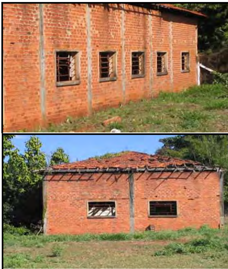
Figura 8: Observação das paredes frontal e lateral do Engenho.
