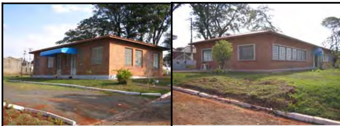
Figura 19: As primeiras instalações do complexo a serem recuperadas: recepção e secretaria (imagem à esquerda) e salas de aula e laboratórios (imagem à direita).
