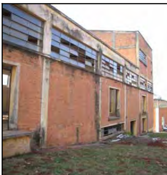
Figura 24: Instalação do complexo que já está passando por uma reforma inicial em sua parte interna.
