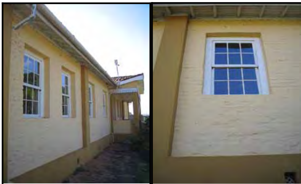
Figura 34: Detalhes da preocupação com a manutenção das características originais da construção.
