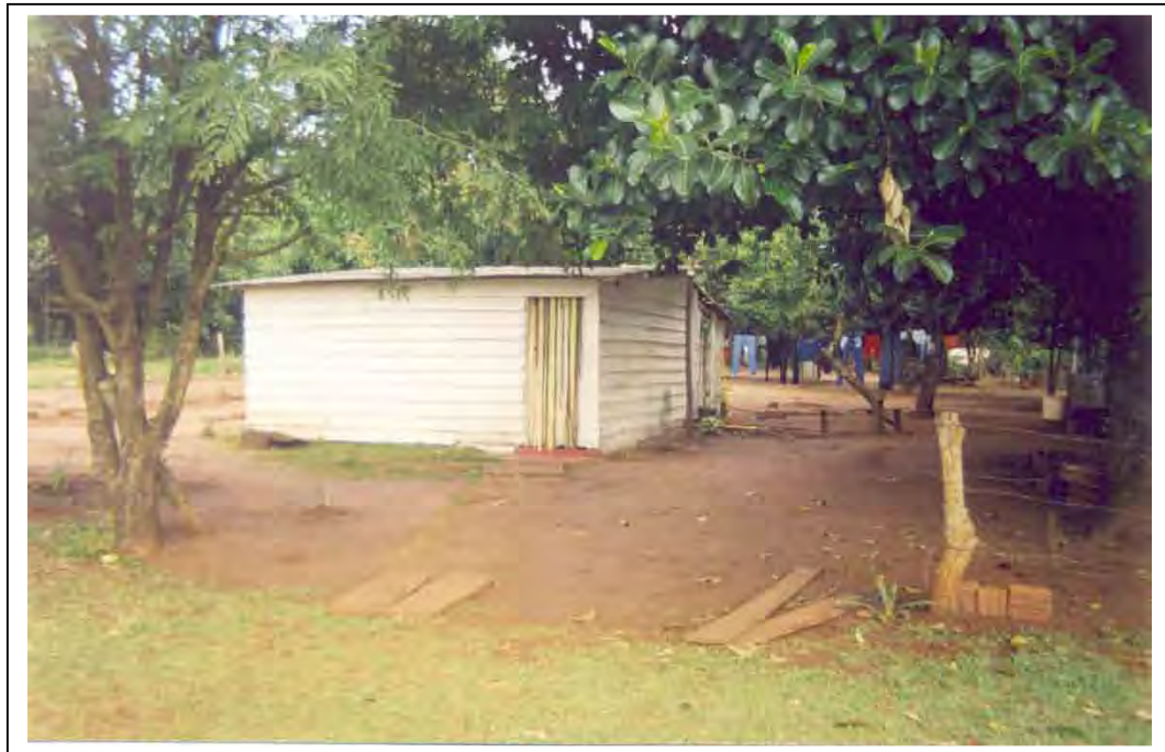
Foto 3- Casa de madeira construída na agrovila durante a implantação do Reassentamento, em 1986. Autor: Mendes, N. A. S. (2003)
