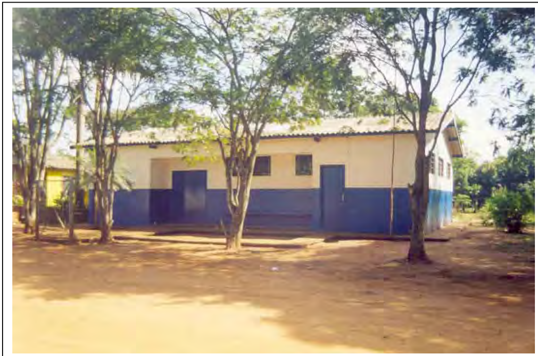
Foto 6- Vista Parcial de Posto de Saúde localizado no Ressestamento de Rosana. Autor: MENDES, N. A . S. (2003)
