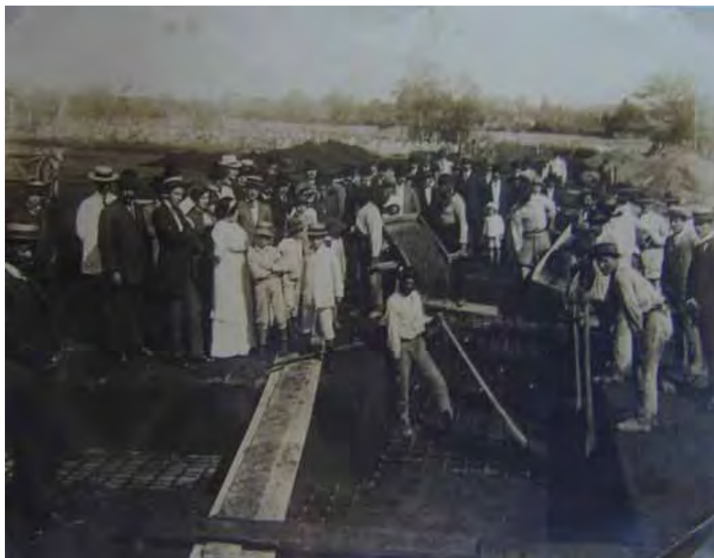
Figura 2: Foto da construção da Escola Normal de Piracicaba.
