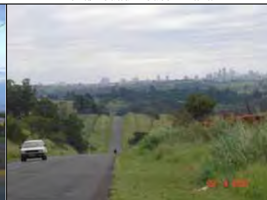
Figura 24 – Trecho da Rodovia Ângelo Rena/Fouad Yousef Makari
