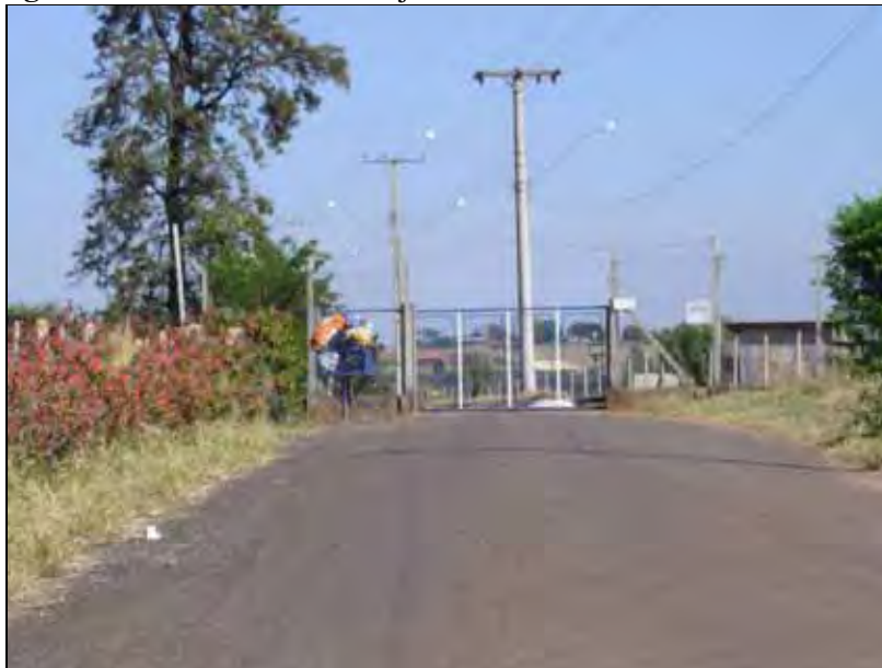
Figura 30 – Entrada de um conjunto de chácaras em Álvares Machado
