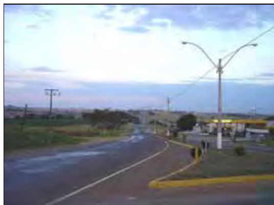
Figura 23 – Trecho da Estrada da Amizade
