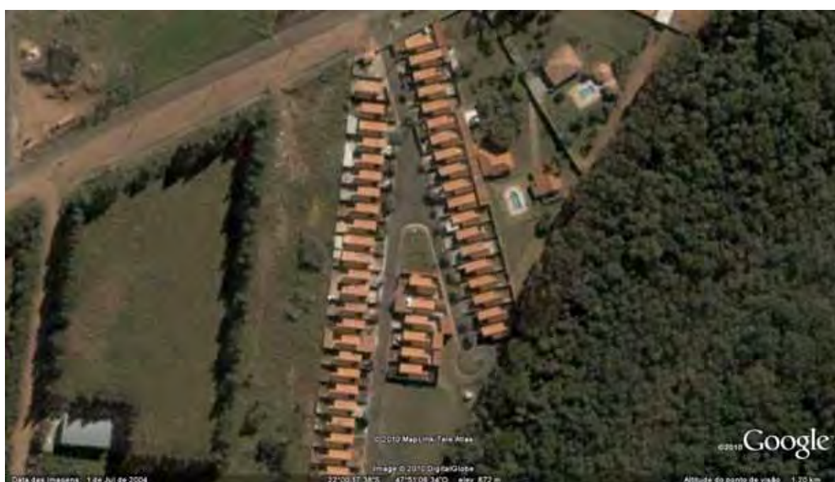
Imagem 24: Residencial Tecumseh Village (São Carlos). Exemplo de espaço residencial fechado com residências de padrão construtivo de características populares.
