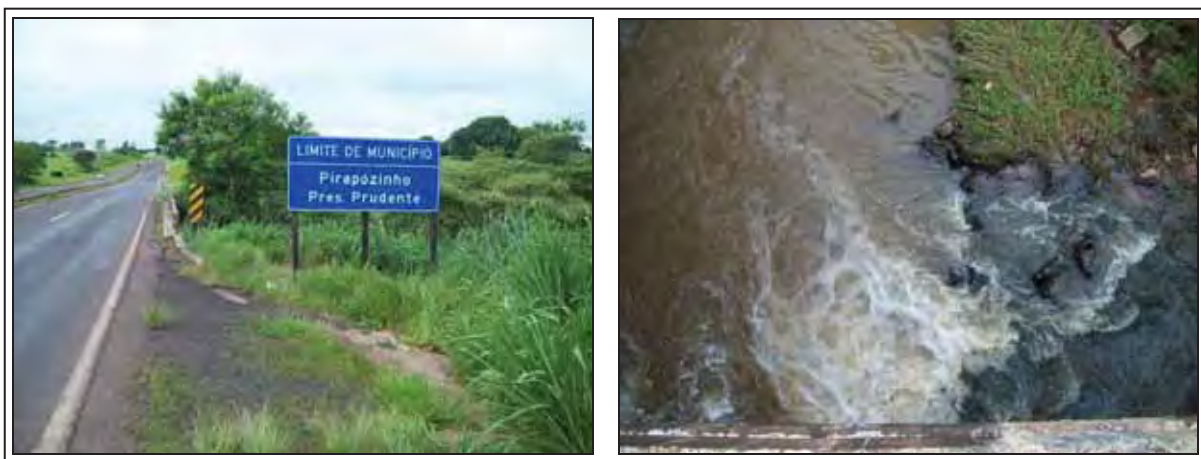
Figura 33: Fotos da Rodovia Assis Chateaubriand e Seção 2.
