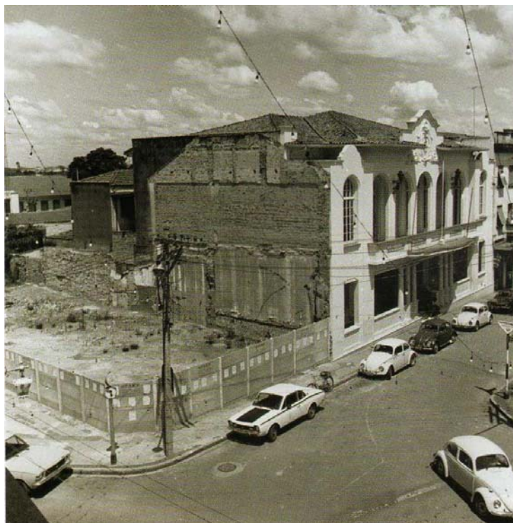
Figura 11: Demolição ocorrida no Eixo Histórico (Praça Padre Miguel).
