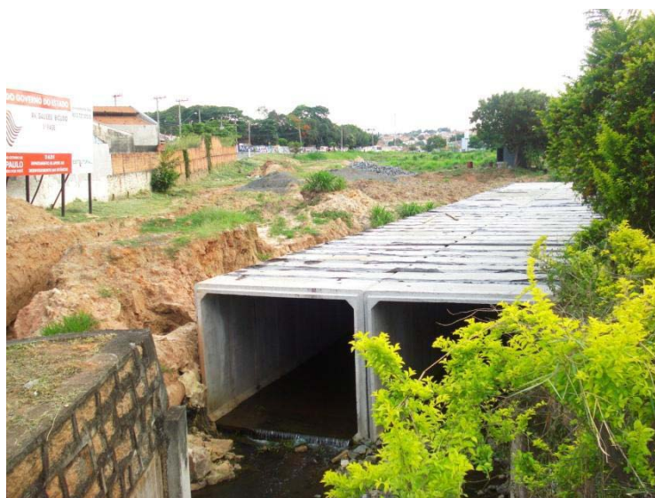
Figura 10: Obra de canalização de trecho do ribeirão Brochado. À esquerda, o Centro. À direita, o Jd. Santana.
