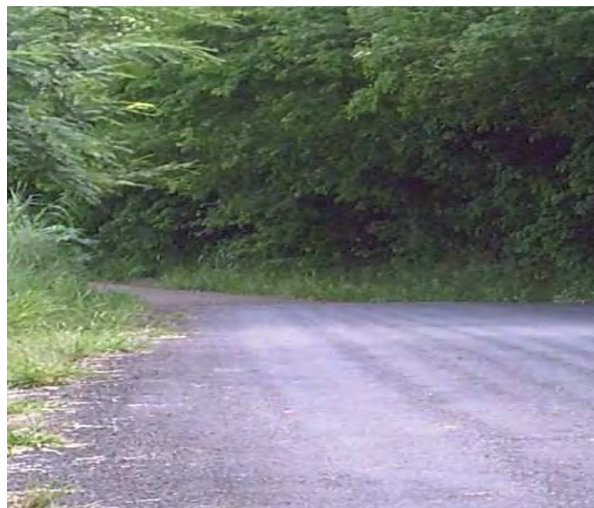
Foto 14 – Estrada no Bairro Aeroporto. Na foto, nota-se a Estrada Bom Pastor (Aeroporto) no percurso que deixa de ser pavimentada. Autor: Erika Vanessa Moreira – Pesquisa de Campo (março de 2006).
