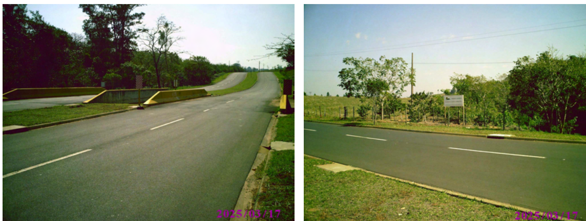
Foto 15 – Área limite entre Bairro Cedro e São João. Na foto à esquerda, observa-se a Avenida Miguel Damha e a ponte sob o Córrego do Cedro. Na foto à direita, tem-se uma área de preservação permanente, sob cuidado do grupo Encalso. Autor: Leandro Bruno dos Santos – Pesquisa de Campo (agosto de 2006).
