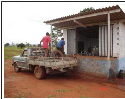
Foto 14 Tanque de resfriamento localizado no assentamento Vale Verde município de Teodoro Sampaio-SP
