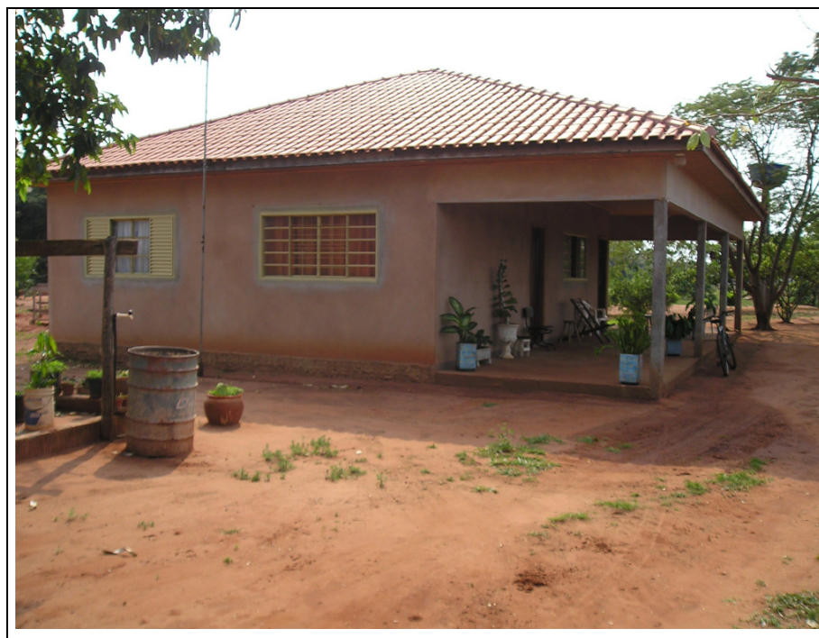
Foto 01: Casa de alvenaria no Assentamento Rodeio
