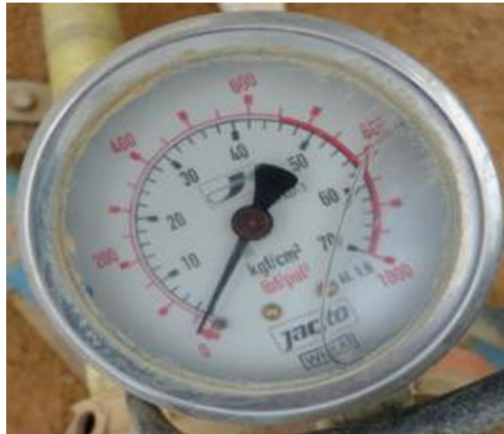
Figura 8: Manômetro com ponteiro acima do ponto zero com sistema sem pressão. Petrolina – PE, 2011.
