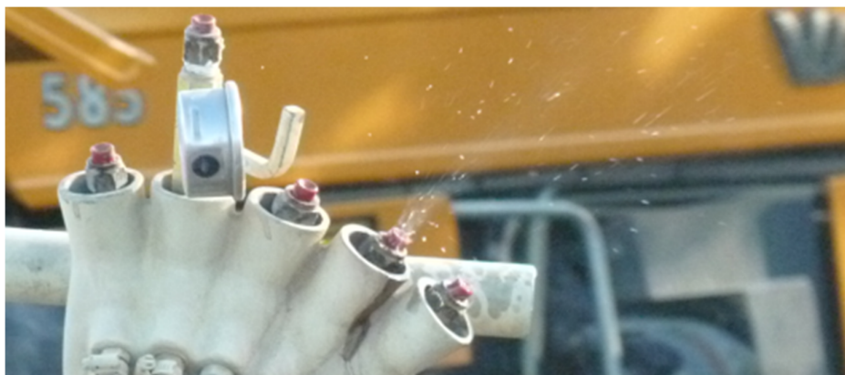
Figura 4: Perdas por vazamentos entre a ponta e sua capa de engate. Petrolina – PE, 2011.
