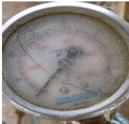
Figura 7: Manômetro com baixa visibilidade devido à sujeira. Petrolina – PE, 2011.
