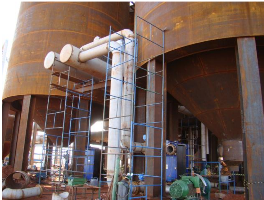
Figura 3 - Instalação dos fermentadores, bombas e trocadores.
