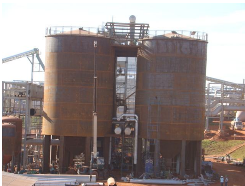
Figura 12 - Instalação dos fermentadores.
