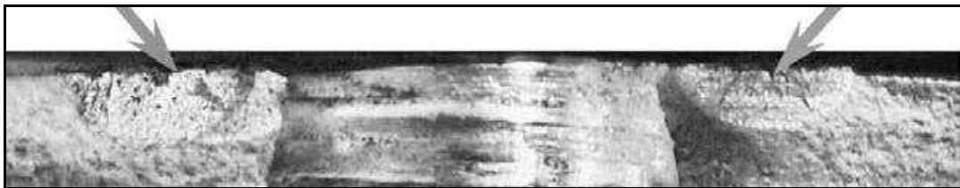
Figura 20 - Trinca para força de aperto alta (SKORUPA et al, 2009)
