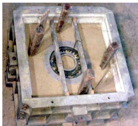
Figura 60 - Assentamento da terceira caixa
