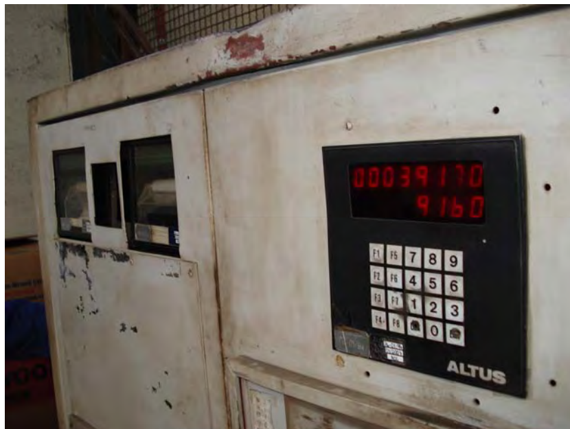
Figura 29 – Foto do painel de controle da marca ALTUS do forno de tratamento térmico.
