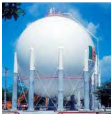
Figura 1 – Vaso de pressão esférico (CONFAB EQUIPAMENTOS).
