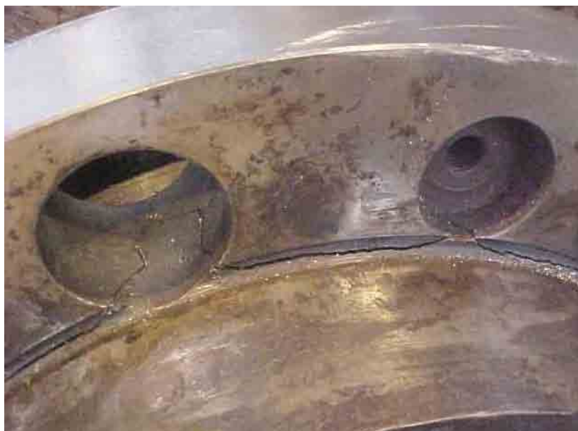
Figura 5.9 - Detalhe da posição da trinca entre o nariz e a aba da árvore
