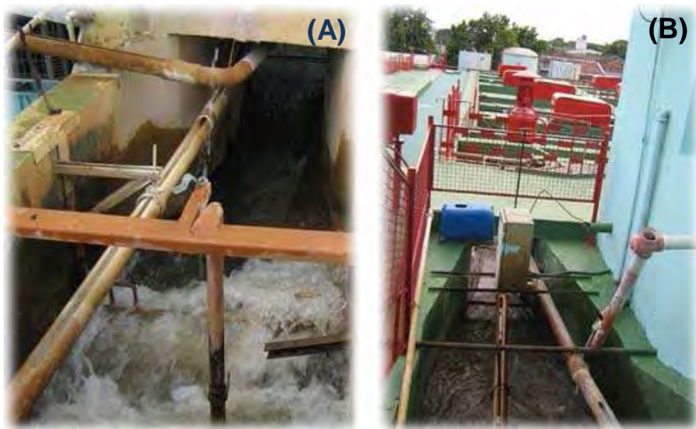
Figura 13: Fotografias da entrada do esgoto bruto na ETE de Monjolinho no município de São Carlos. (A) Vista próxima. (B) Vista Ampla.
