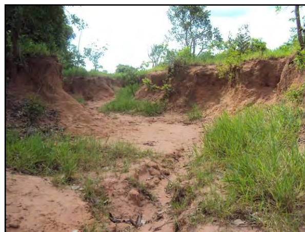
Figura 10.: Ravinamento nas imediações da estação de tratamento de esgotos (2009).
