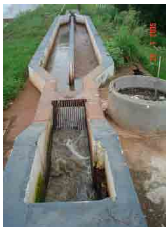
FIGURA 6. Ponto 1 ETE (esgoto bruto).
