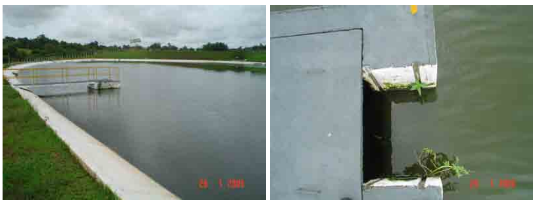
FIGURA 7 - Ponto 2 ETE (Efluente Final).
