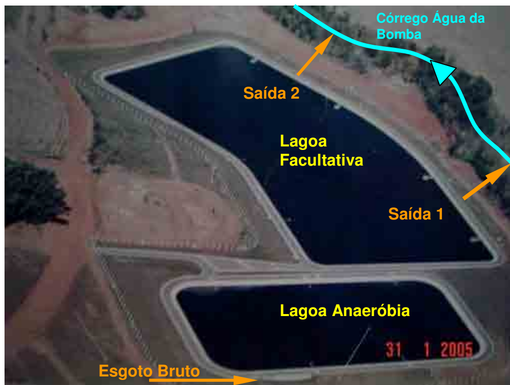
FIGURA 5. Foto aérea da ETE Regente Feijó.
