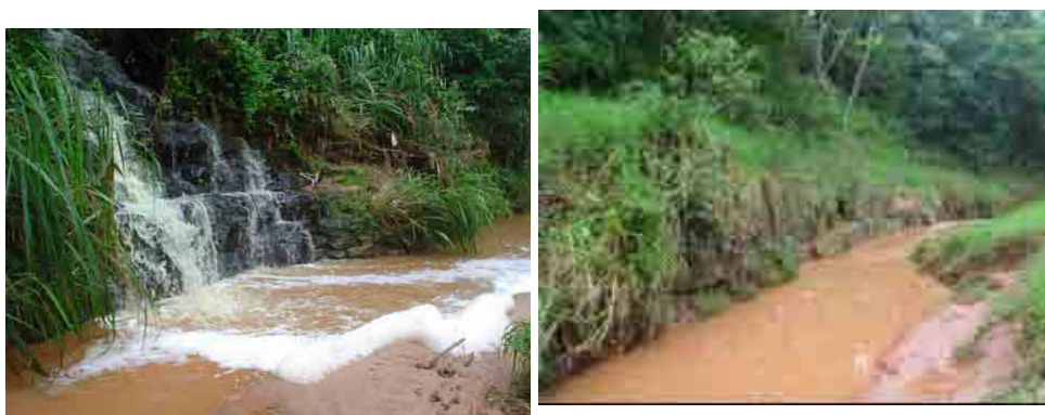
FIGURA 13. Foto do lançamento seguida de foto do Ponto 3 (Jusante).
