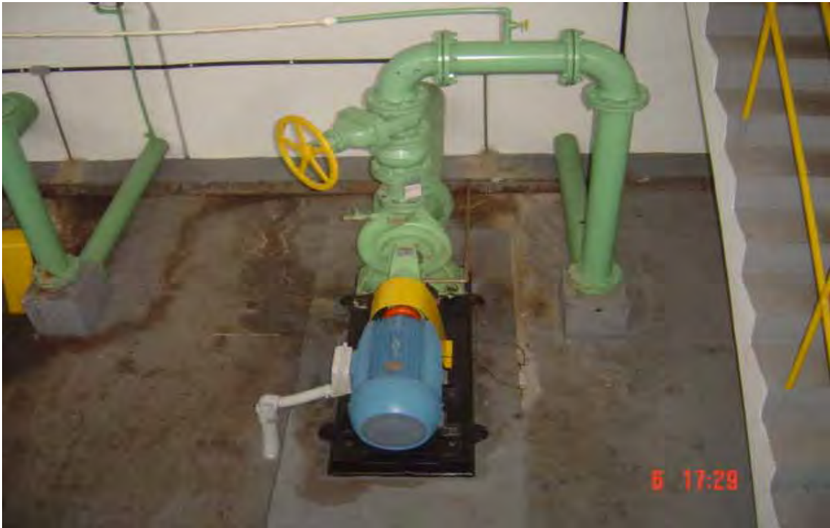
Uma vista do barrilete de recalque de uma das bombas do sistema Alto ETA
