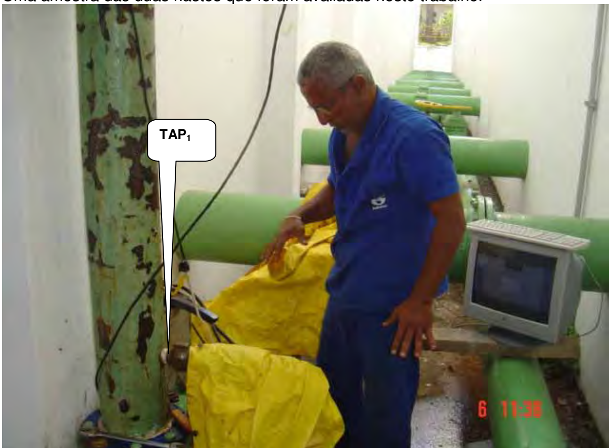
Preparando os equipamentos para a substituição de hastes.
