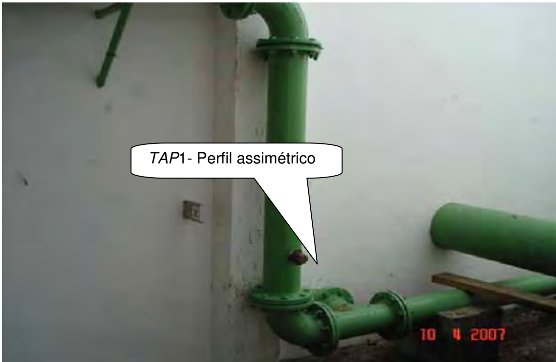
Figura 29 – TAP_1 instalado em local de assimetria axial do perfil de velocidade
