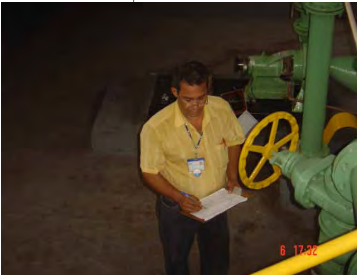
Estas bombas operam variando velocidades, por meio de conversores de frequência e sensores de pressão
