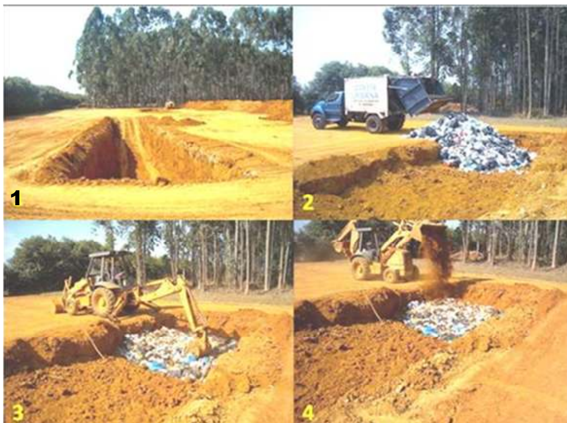
Figura 16: 1) Abertura das valas; 2) Descarga de resíduos em um único ponto da vala, em colunas; 3) Compactação com maquinário disponível; 4) Cobertura diária com solo.
