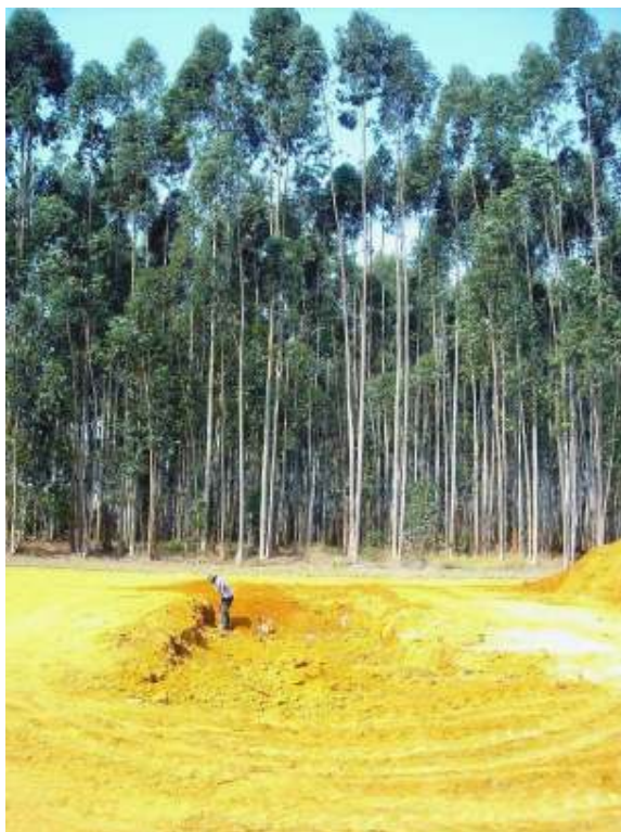
Figura 17: Camada de cobertura final dos resíduos aterrados.
