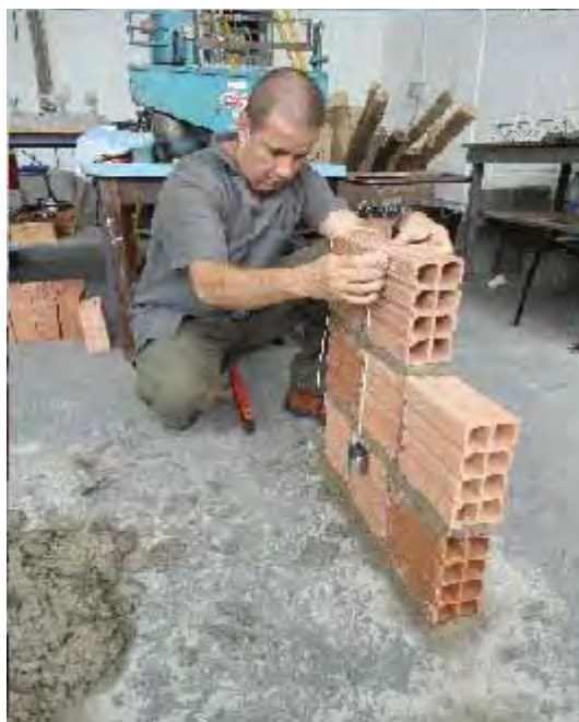
Figura 14 - Construção do substrato para realização do ensaio.
