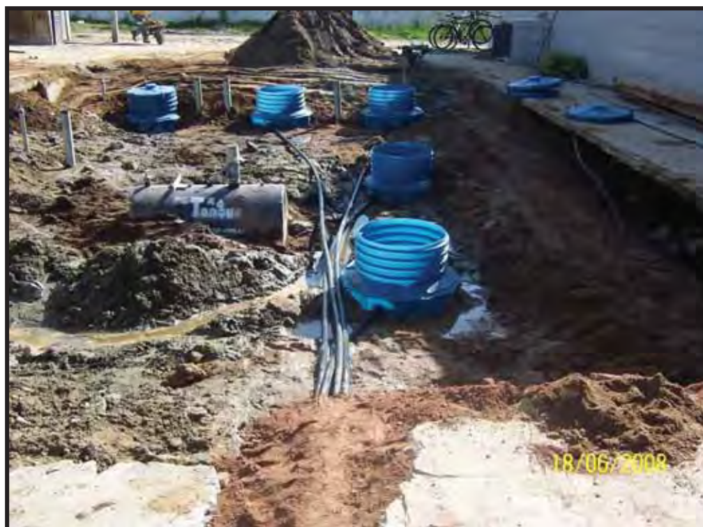
Figura 21 – Instalação de tanques ecológicos na área do Auto Posto Praia das Palmeiras Ltda. (Construfer, 2008).
