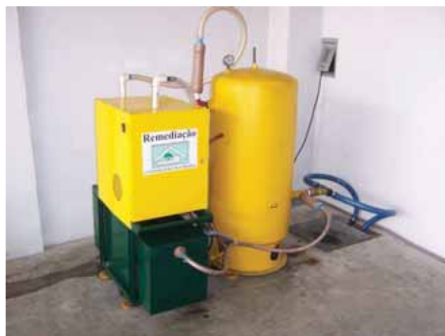
Figura 11 - Sistema de bombeamento e tratamento aplicado à remediação de aquíferos contaminados por derivados de petróleo (Construfer, 2008 ).
