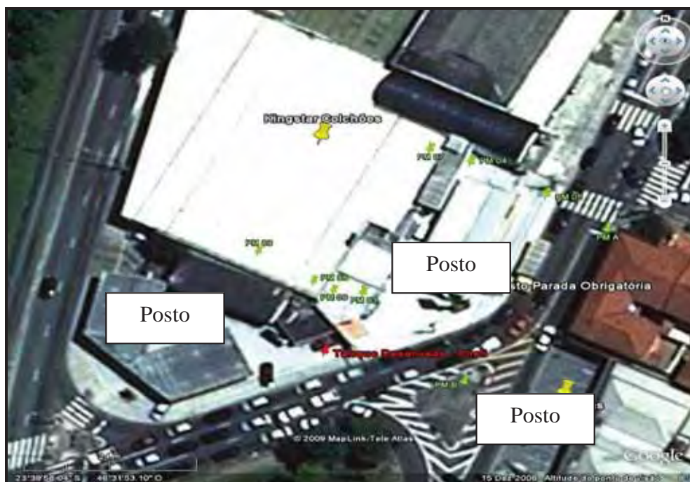
Figura 24 – Entorno crítico ao Auto Posto Parada Obrigatória Ltda., Santo André/SP (Construfer, 2009).
