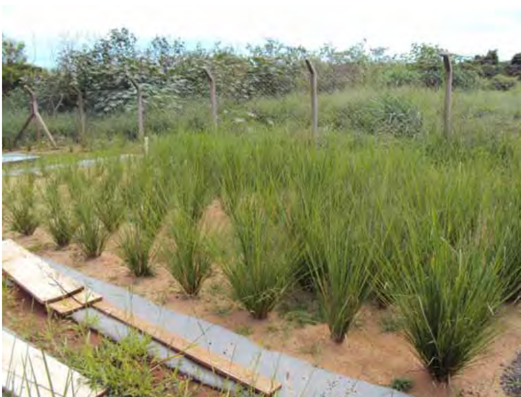
Figura 25: Faixa inicial de um dos leitos de fluxo horizontal.
