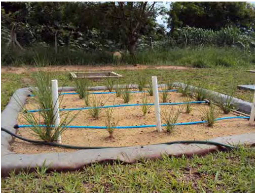
Figura 13: Tanque 1V, preenchido com pedra e camada superficial de areia (Foto: Larissa Miranda-Santos)
