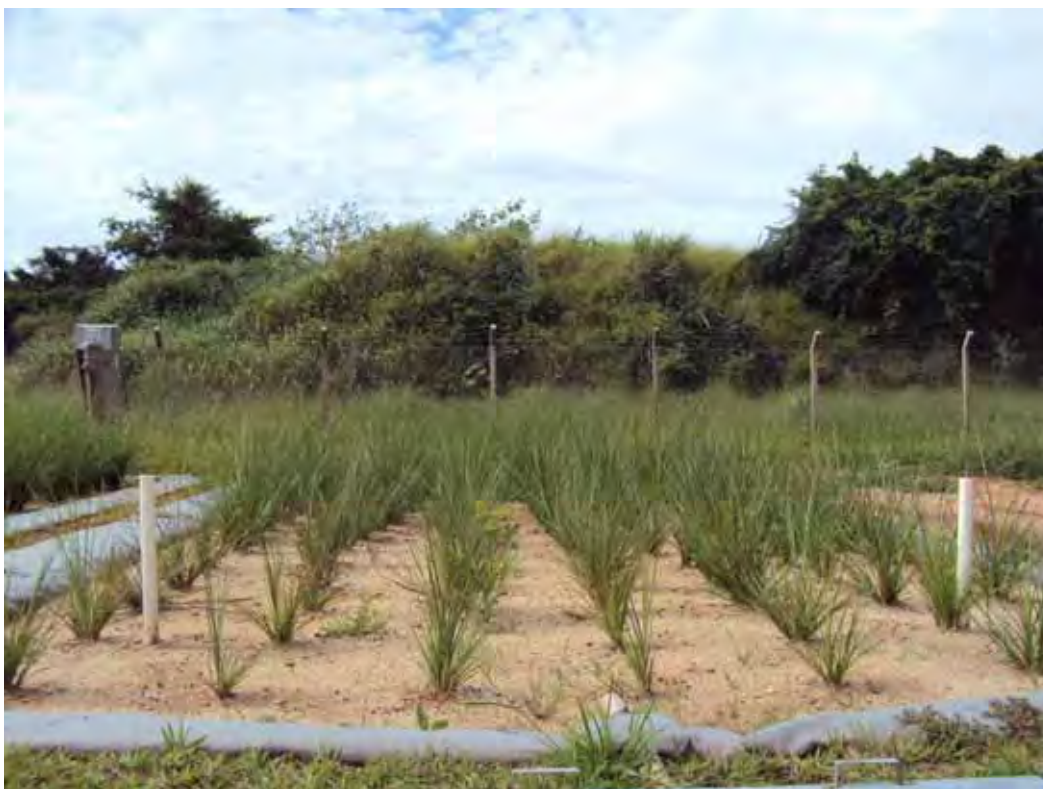
Figura 10: Tanque 1H, preenchido com pedra e areia na camada superficial (Foto: Larissa Miranda-Santos)
