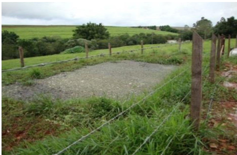
Figura 13: Tanque de decantação enterrado no solo
