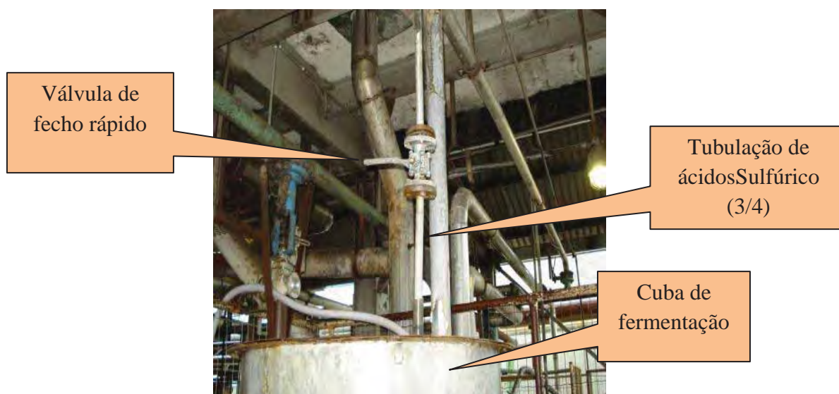
Figura 6 – Cuba de fermentação e tubulação de ácido sulfúrico. Fonte: Empresa de açúcar e álcool. Município Y, São Paulo, 2006 a 2009.
