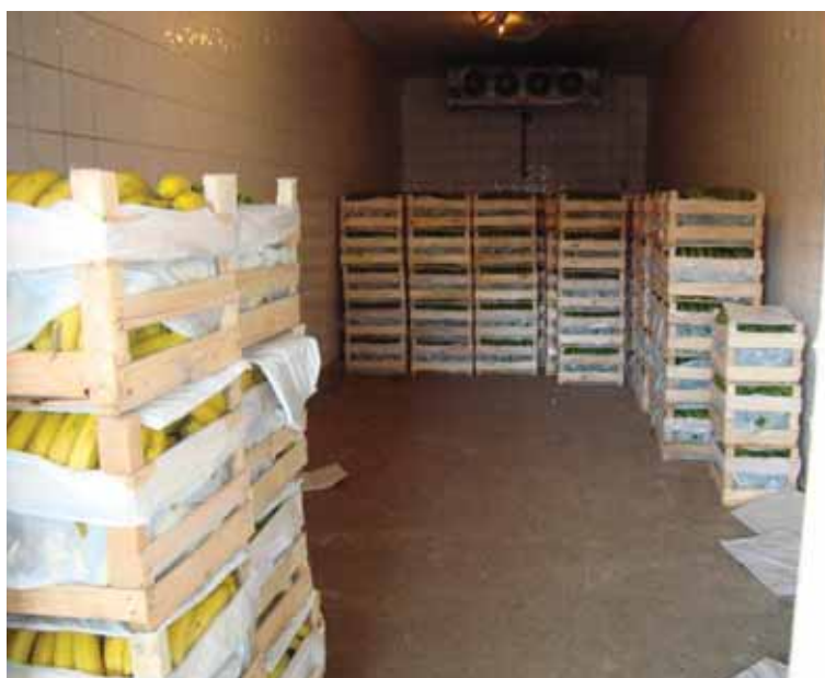
FIGURA 15. Câmara de climatização de frutas com caixas de madeira de 22 kg de bananas, sendo climatizadas na Associação dos Pequenos Produtores Rurais da Microbacia Hidrográfica do Córrego da Água Limpa.
