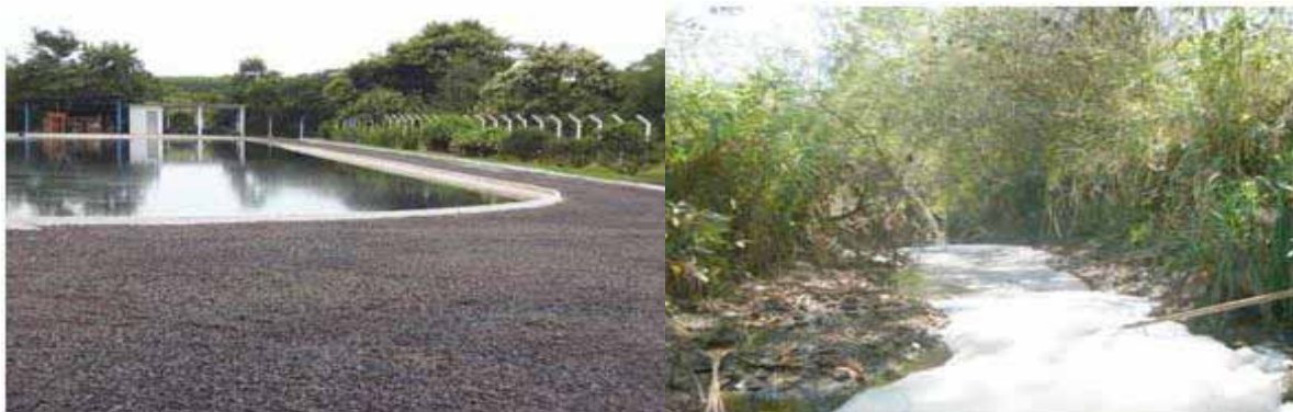
Figura 10 - Estação de tratamento de esgoto (à esquerda) e despejo de efluente (à direita).
