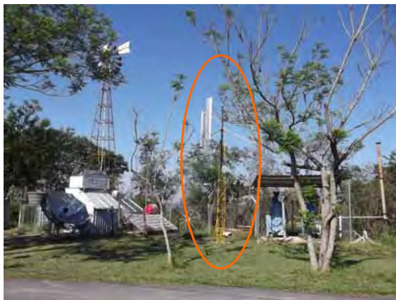
Figura 19 – Local de instalação do aeromotor e presença de anteparos
