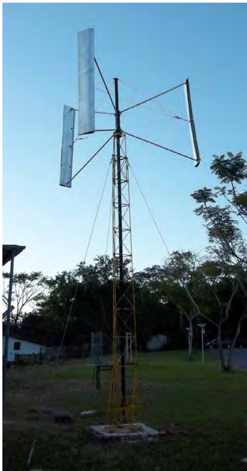
Figura 31 – Aeromotor de eixo vertical – Vista geral
