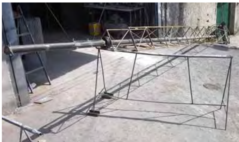
Figura 26 – Eixo de transmissão instalado na torre
