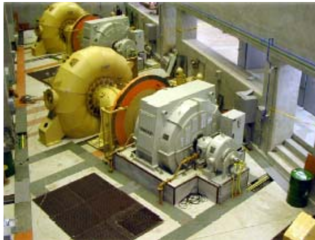
Figura 10: Interior da Casa de Força PCH Rolador (DME)
