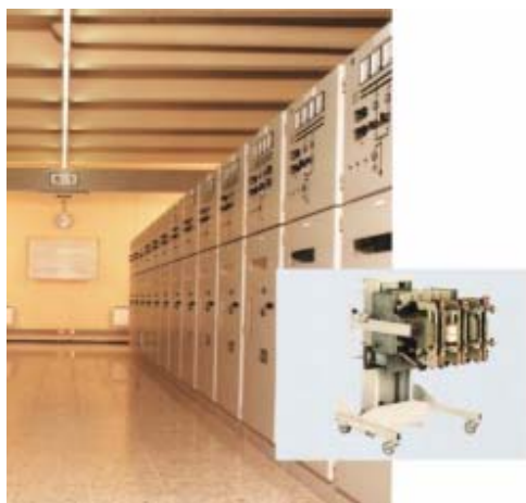
Figura 22: Cubículos de Média Tensão (SIEMENS, 2006)
