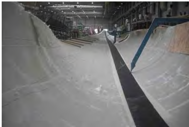
Figura 12: Tecidos de fibra de vidro dispostos sobre um molde de casca. A mesa da viga pré-fabricada encontra-se no meio da casca e parte do núcleo está posicionado à direita da mesa. (Tecsis)
