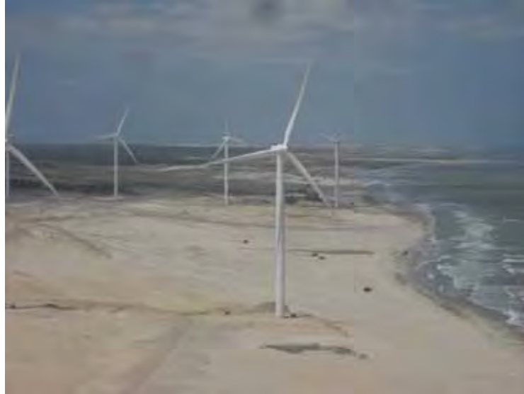
Figura 5: Turbinas de 2 MW em parque eólico cearense. (arquivo pessoal do autor)
