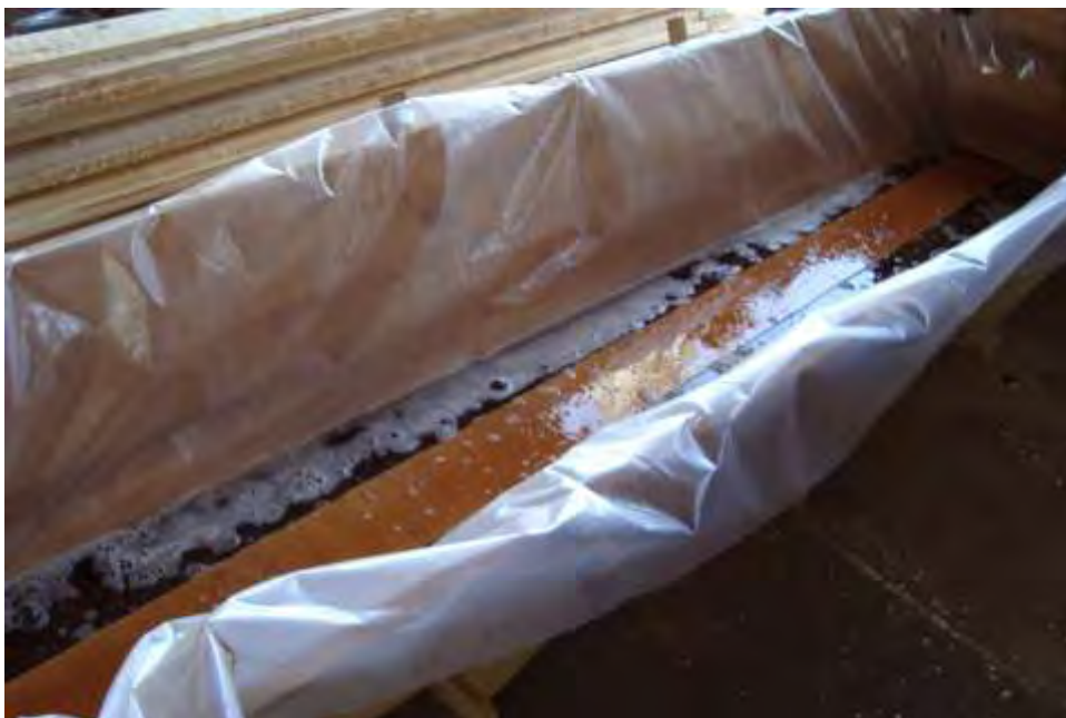
Figura 17. Tratamento de imersão das tábuas em produto preservativo.
