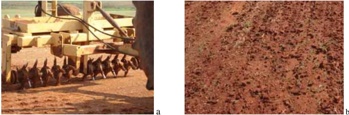
Figura 4. a - Passagem do escarificador “estrelinha”; b - após a passagem do escarificador “estrelinha”
