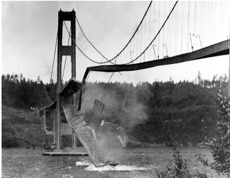
Figura 4 – Queda da ponte do estreito de Tacoma, EUA – vibração induzida por vórtices e ressonância.
