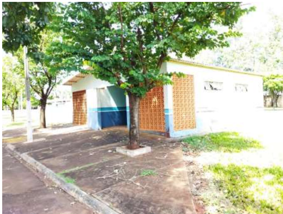
Figura 12 – Banheiro localizado na lateral esquerda do palco
