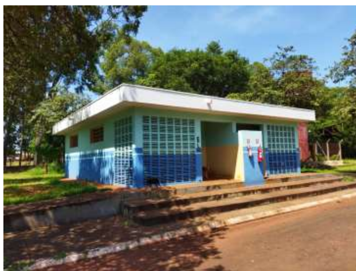
Figura 13 – Banheiro localizado na lateral da Barraca Central
