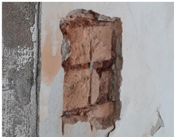
Figura 42: Alvenaria assentada em terra
