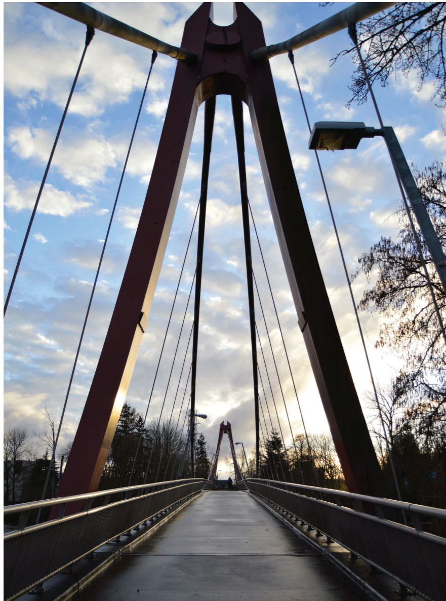
Exemplo de passarela de pedestres e ciclistas no rio Willamette, em Eugene Fonte: autor
