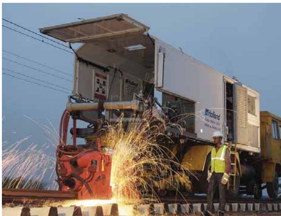
Figura 14 - Soldagem de trilhos por caldeamento em campo.
