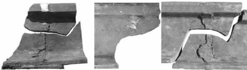
Figura 20 - Trincas horizontais na alma. [19]
