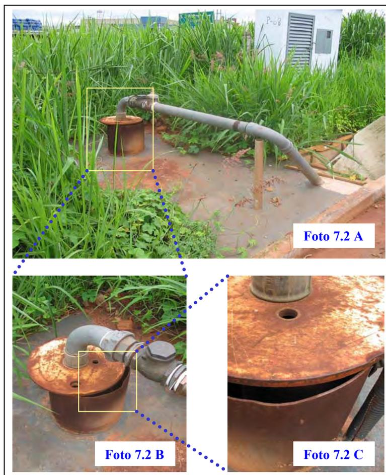
Fotos 7.2 A, B e C - Tampa do tubo de boca não alinhada e sem vedação.
