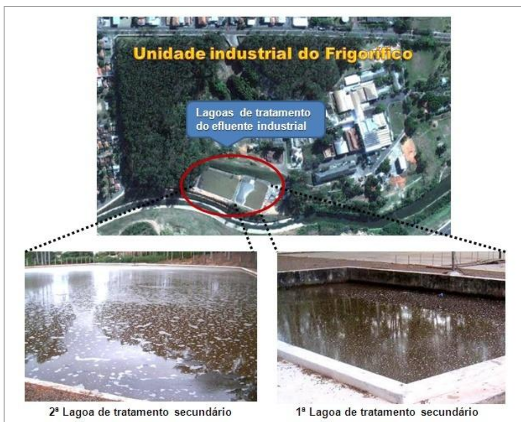
Figura 7. Unidades de tratamento secundário da ETE do frigorífico.
