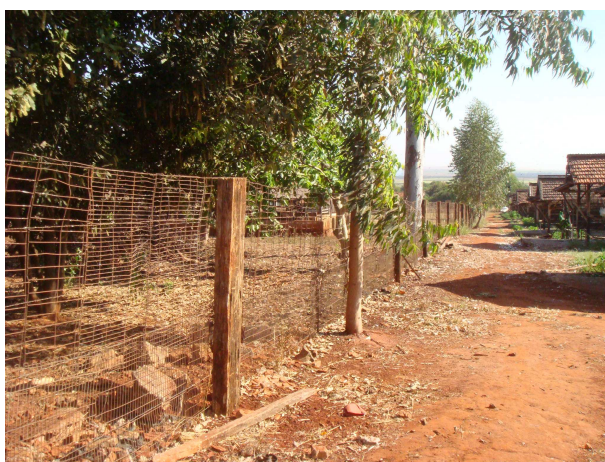
Figura 3- Cerca de isolamento da granja construída com a estrutura de gaiolas antigas
