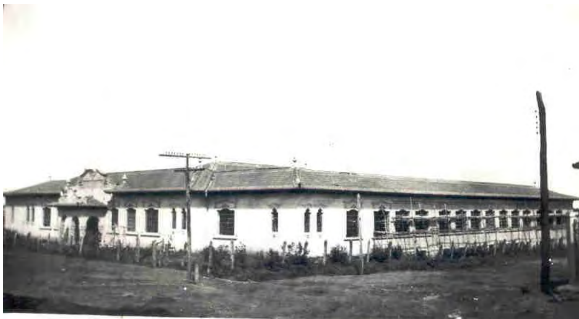
FIGURA 8 - Vista parcial da construção – lado direito (1951)
