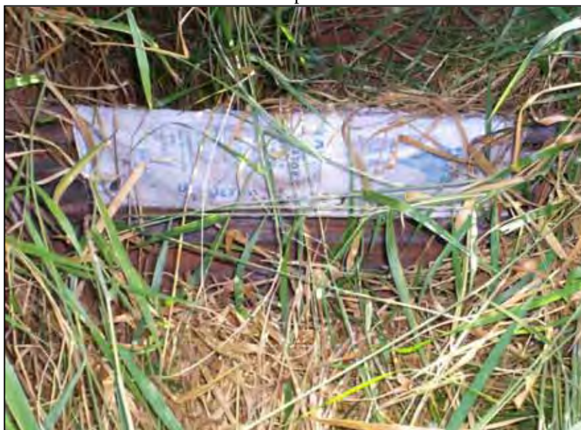
Figura 59 – Barreira de bambus instalada na parte à montante de um canal de escoamento.
