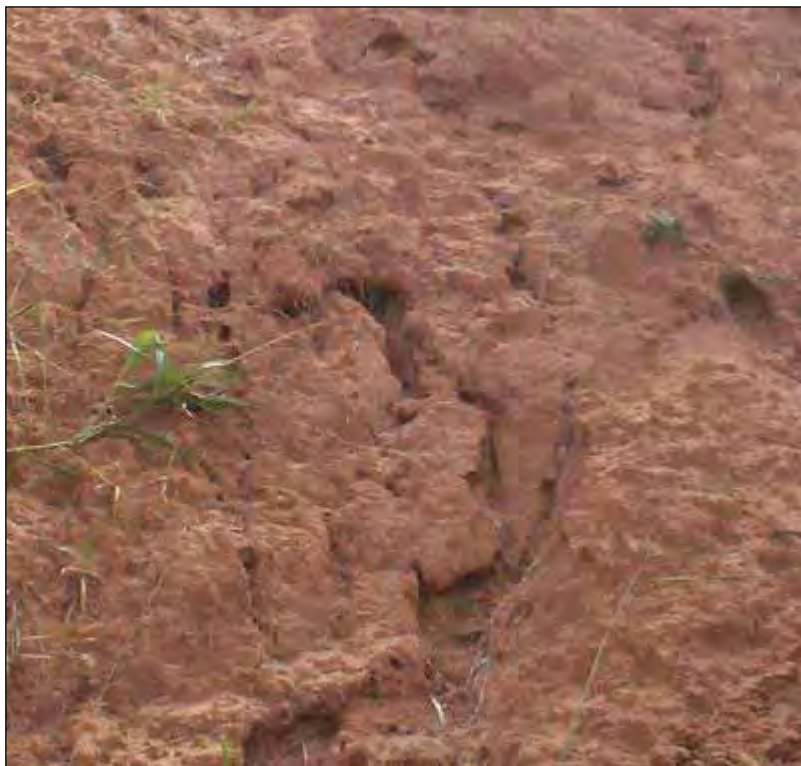
Figura 45 – Dutos gerados por erosão interna ( piping ).
