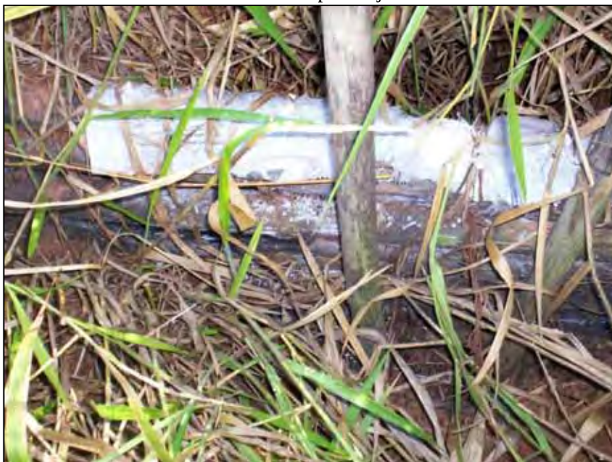
Figura 60 – Barreira de bambus instalada na parte à jusante de um canal de escoamento.
