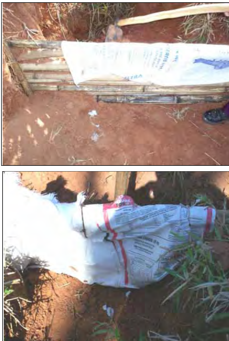
Figura 11 – Fotos das barreiras de bambus cobertas com sacos de ráfia.
