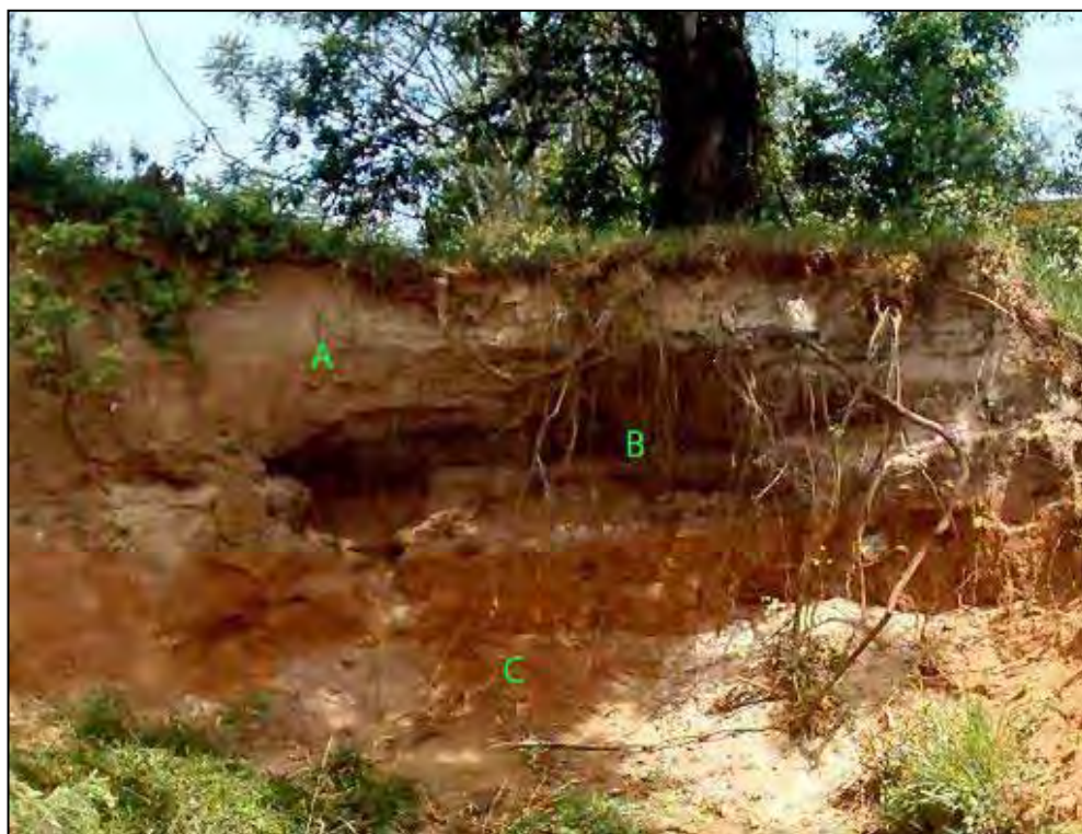
A: Camada arenosa; B: Camada argilosa; C: Arenito da Formação Adamantina. Francisco (abr. 2009).
