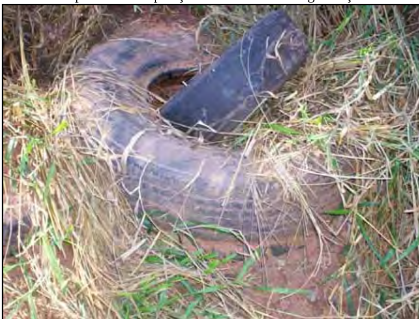
Figura 58 – Barreira de pneus com deposição de sedimentos e regeneração da cobertura vegetal.
