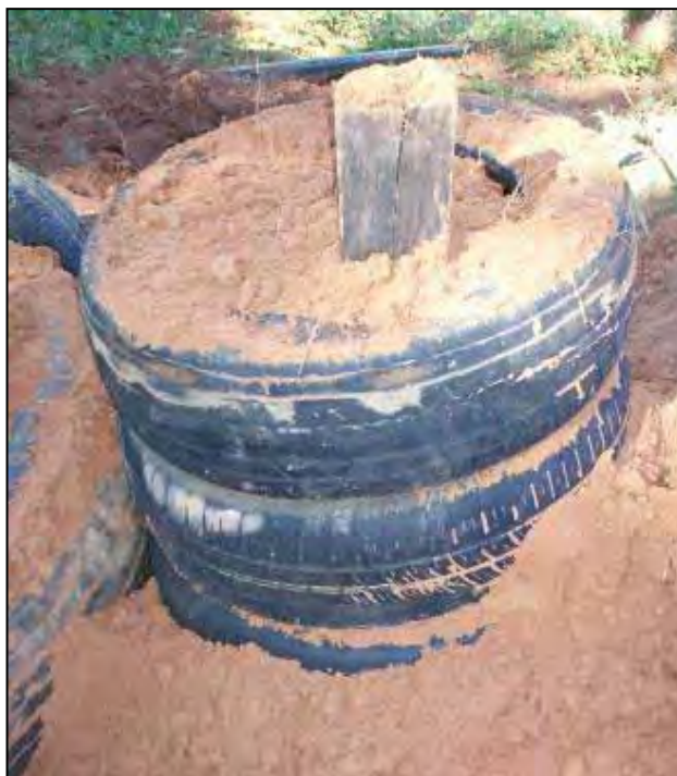
Figura 16 – Foto da coluna de pneus preenchida com terra.
