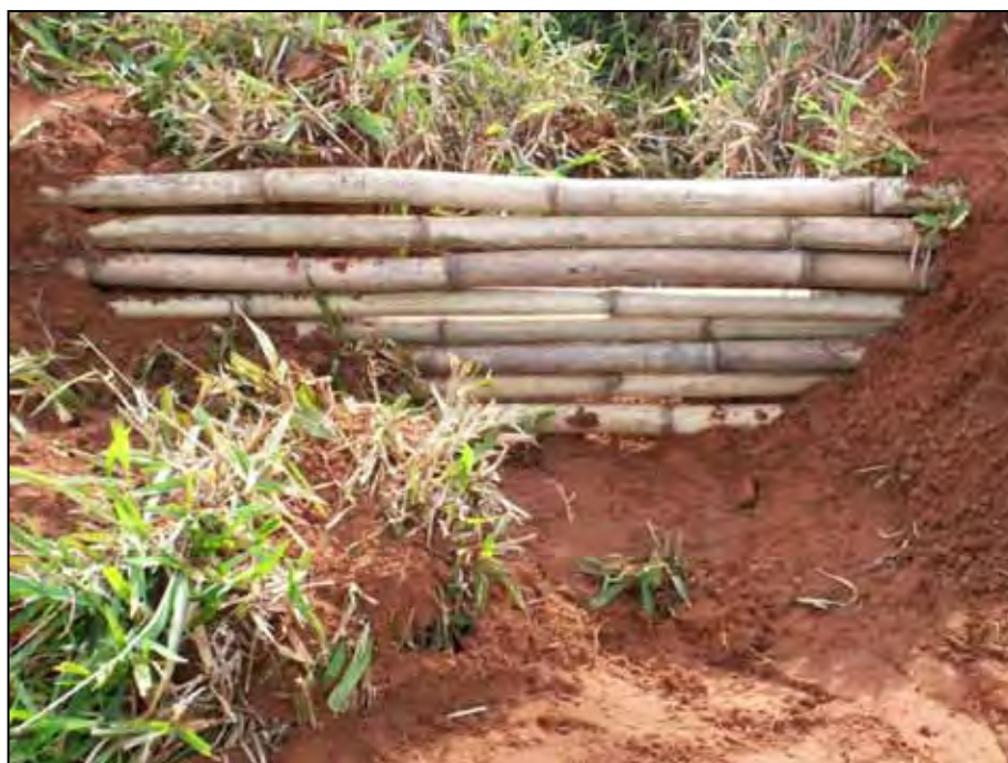
Figura 10 – Foto dos bambus empilhados na horizontal.
