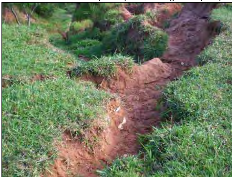
Figura 43 – Solo sem cobertura com a presença de sulcos gerados pelo pisoteio do gado.
