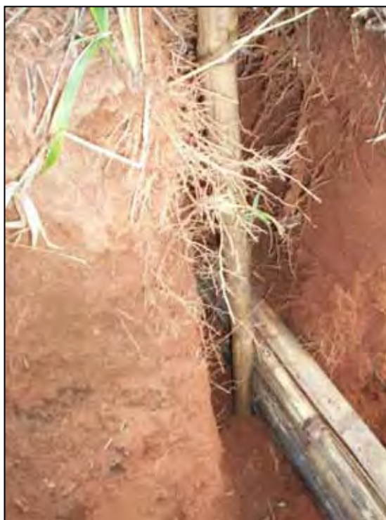
Figura 09 – Foto do corte lateral na parede interna do canal de escoamento como base de apoio para a barreira de bambus.
