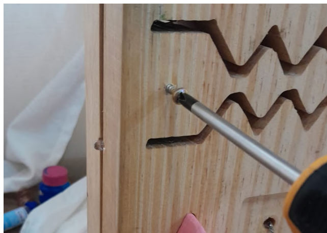
Imagem 76 - Parafusamento paredes
