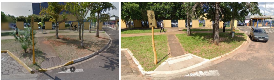
Imagens da calçada do entorno do Hospital Estadual de Bauru em setembro de 2011 e março de 2023, respectivamente.
