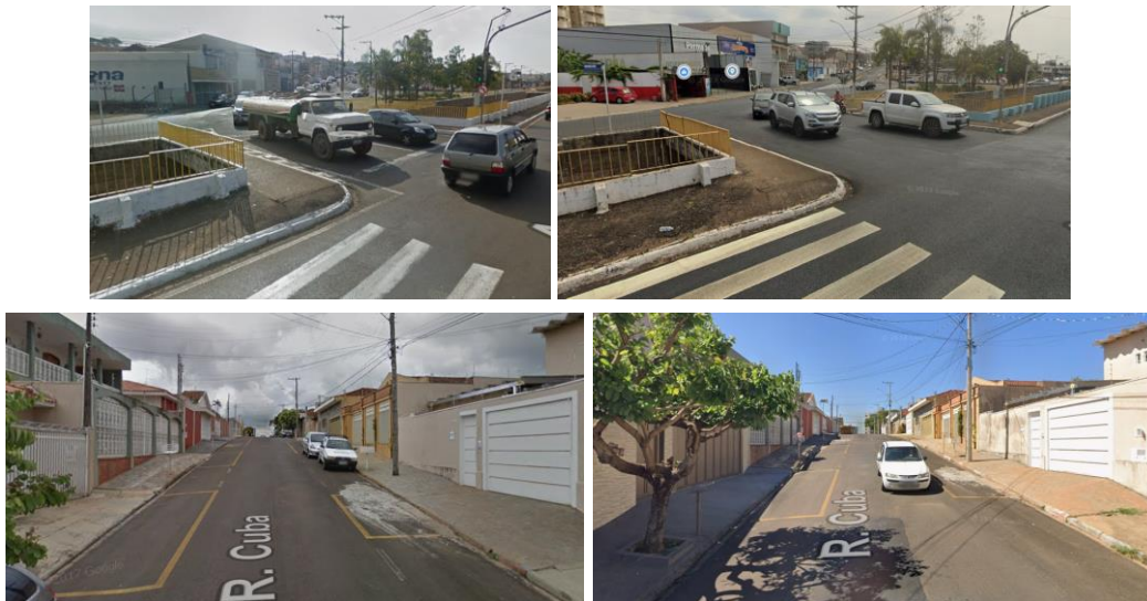
Imagens das calçadas de bairros residenciais da região central, da Av. Antônio Barbosa Filho, 380, em julho de 2017 e agosto de 2022, e da R. Cuba, 1260, em março de 2017 e abril de 2024, respectivamente.
