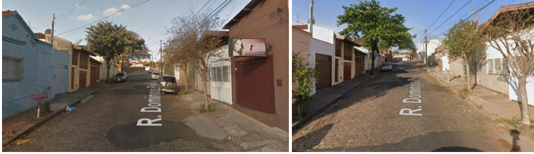
Imagens das calçadas de bairros residenciais da região central, da Av. Duque de Caxias 2-100, em agosto de 2017 e maio de 2023, e imagens da R. Domingos Pleite 4-17, em agosto de 2017 e agosto de 2022, respectivamente
