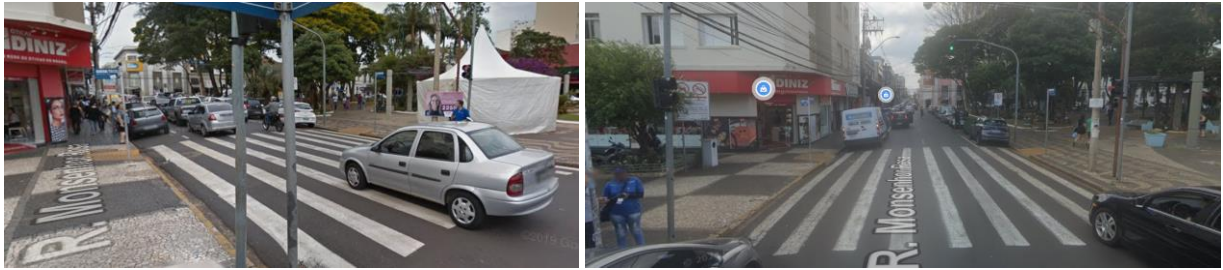
Imagens da calçada do entorno da área do calçadão em outubro de 2018 e setembro de 2023, respectivamente.
