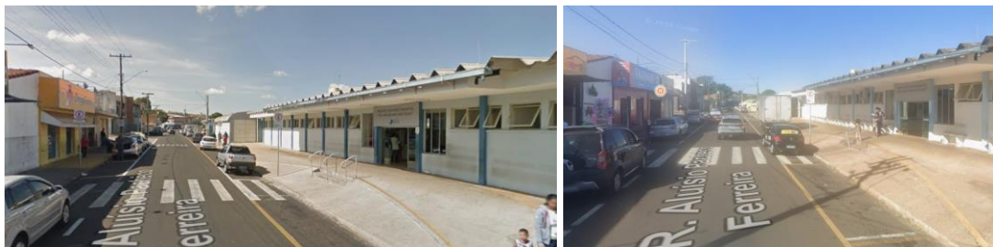
Imagem da calçada do entorno do Pronto Socorro Infantil “Doutor Magid Bachur Filho” em julho de 2017 e maio de 2024, respectivamente.
