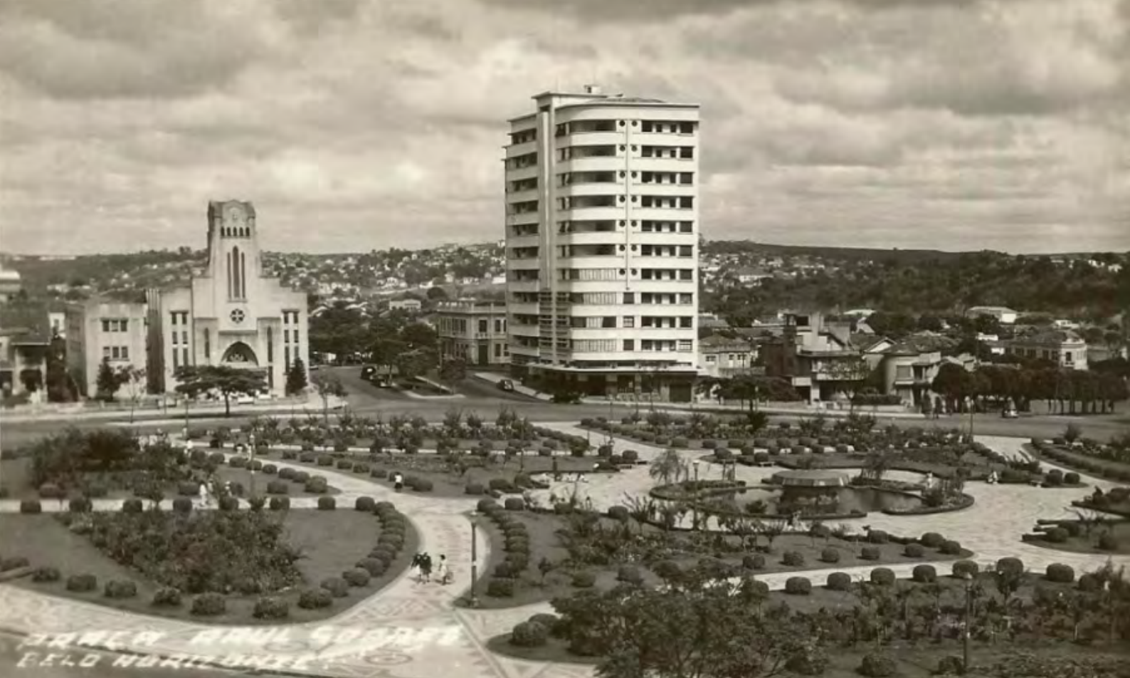
Figura 17 - Primeira Igreja Batista e Edifício Randrade (194-) Fonte: acervo PIB-BH
