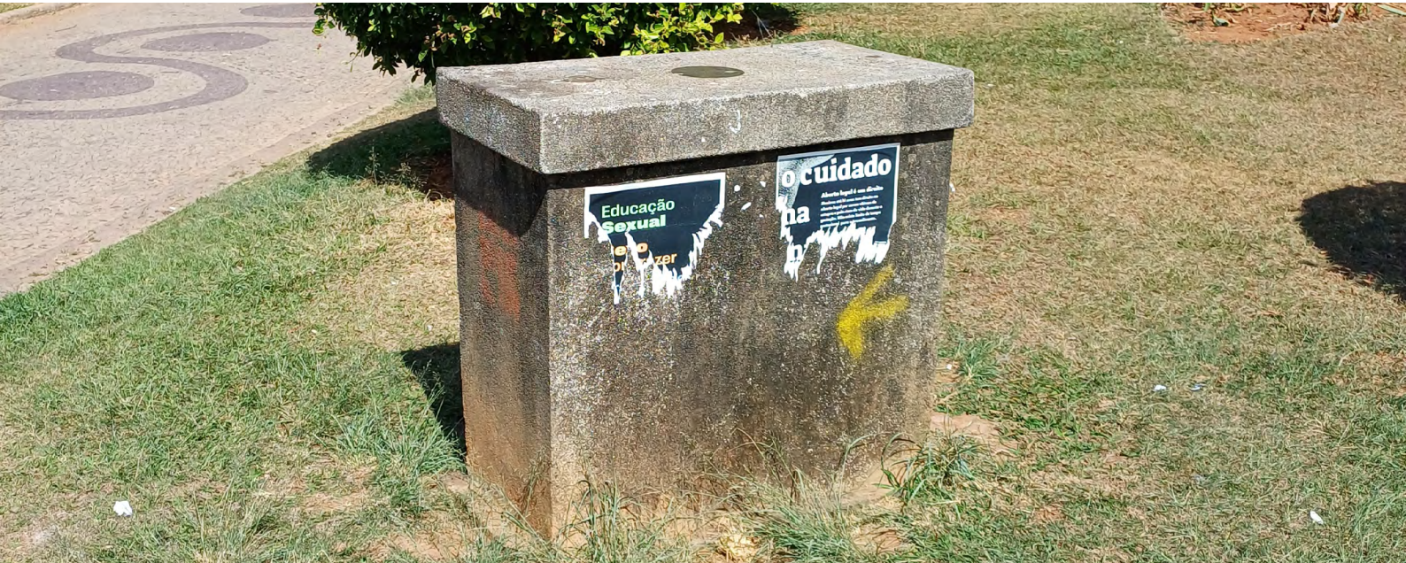
Figura 49 - Marco com referência de nível Fonte: arquivo pessoal (2024)
