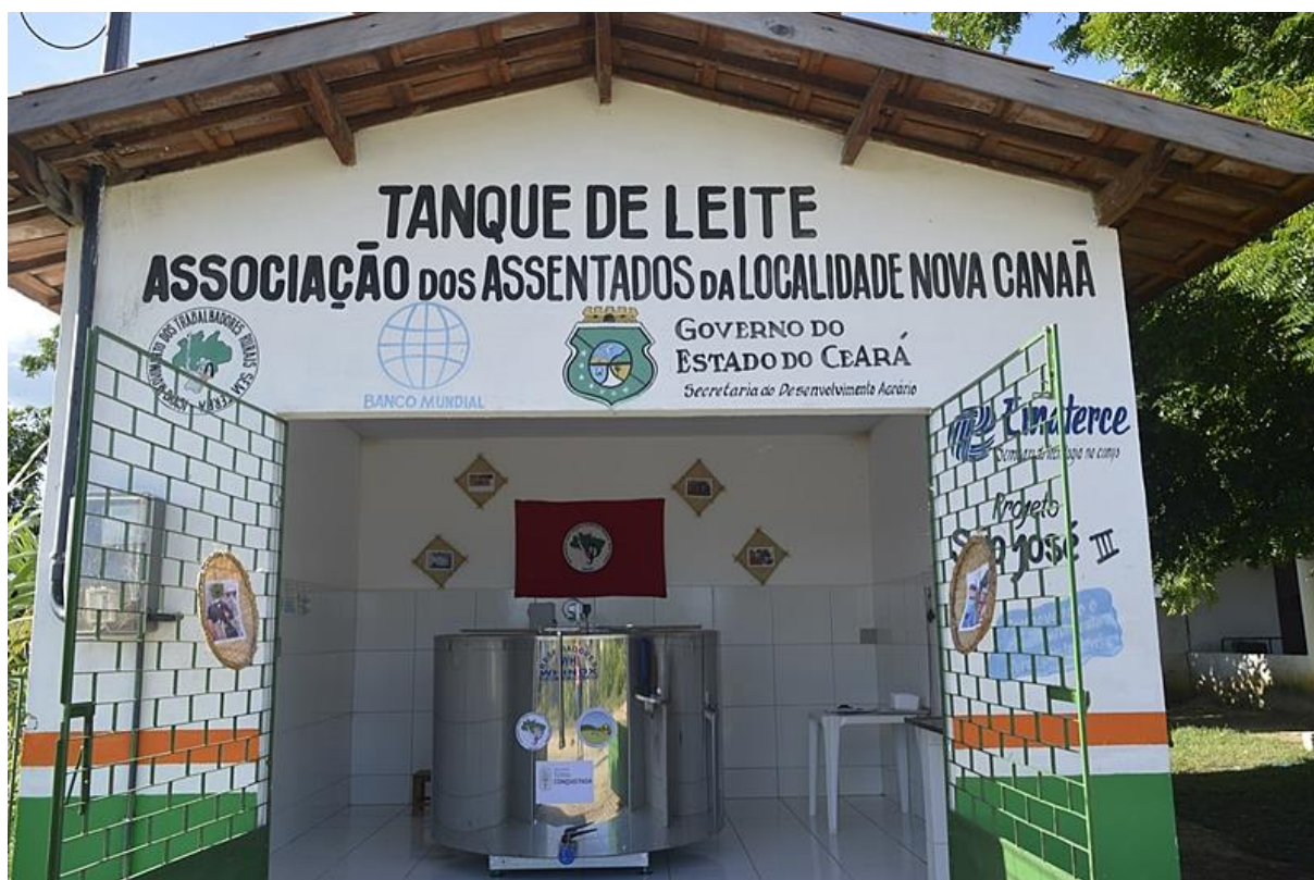
Figura 45: Tanque de Leite no Assentamento Nova Canaã, Quixeramobim.
