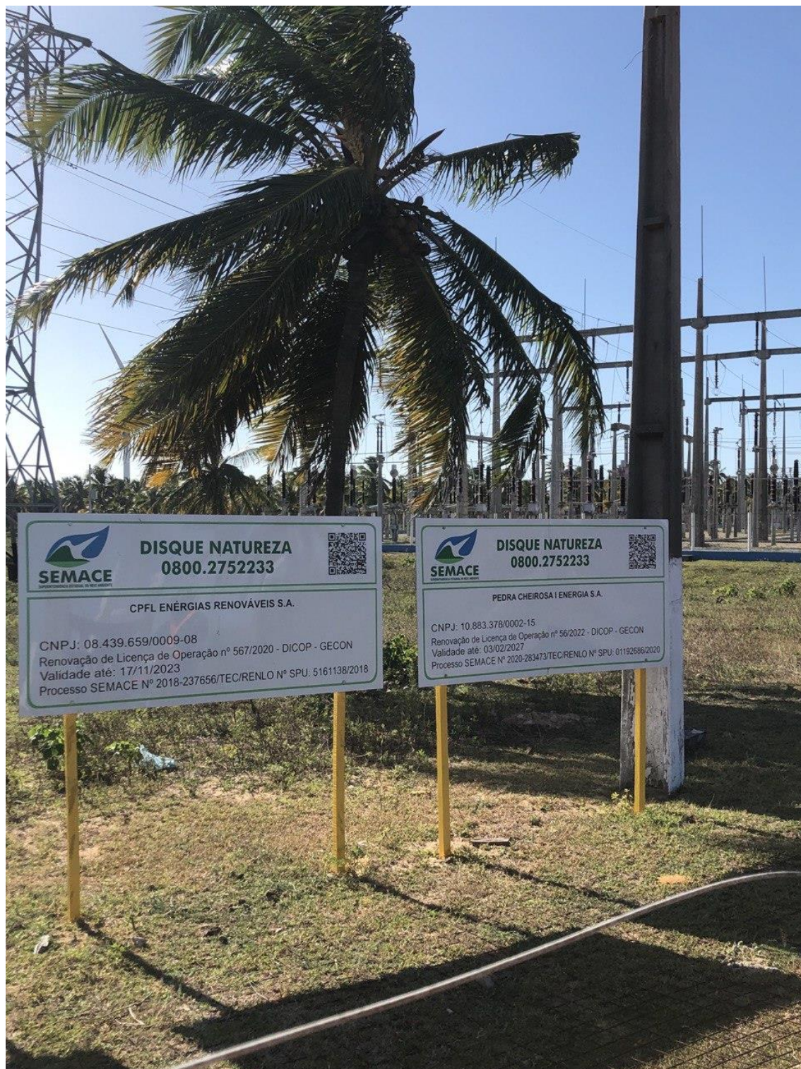
Figura 11: Placas de autorização e licenciamento ambiental da Secretaria de Meio Ambiente do Ceará para os Complexos Eólicos Icaraizinho e Pedra Cheirosa e a subestação de transmissão de energia.
