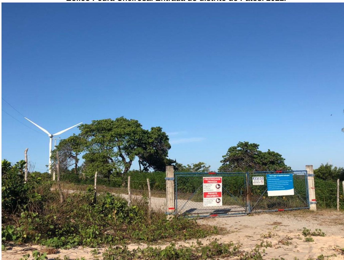
Figura 20: Placas de proibido entrada, aviso de perigo e cercas do Complexo Eólico Pedra Cheirosa. Entrada do distrito de Patos. 2022.
