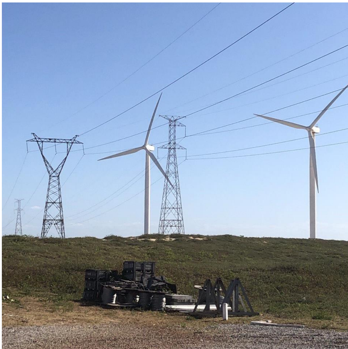
Figura 13: Complexo Eólico Icaraizinho e linhas de alta transmissão de energia próximos à Curva do S e ao escritório da CPFL Renováveis.
