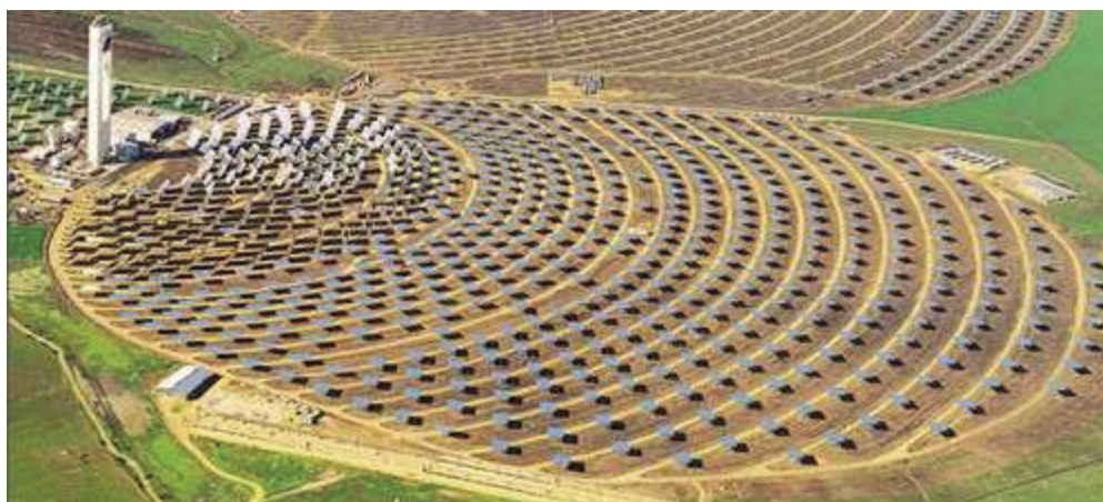
Figura 2. Foto do sistema de receptor central PS10 na Espanha.
