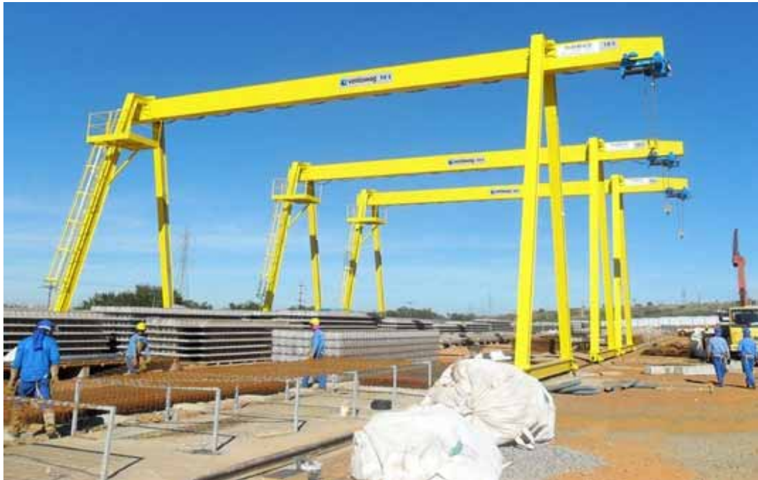
Figura 9 – Pórtico rolante tipo uni viga.
