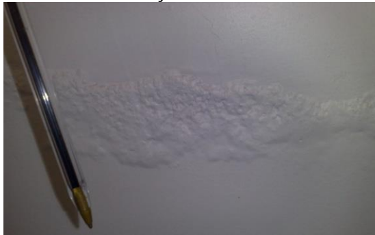
Figura 1. Primeira fase das biodeteriorações: formação de bolhas.
