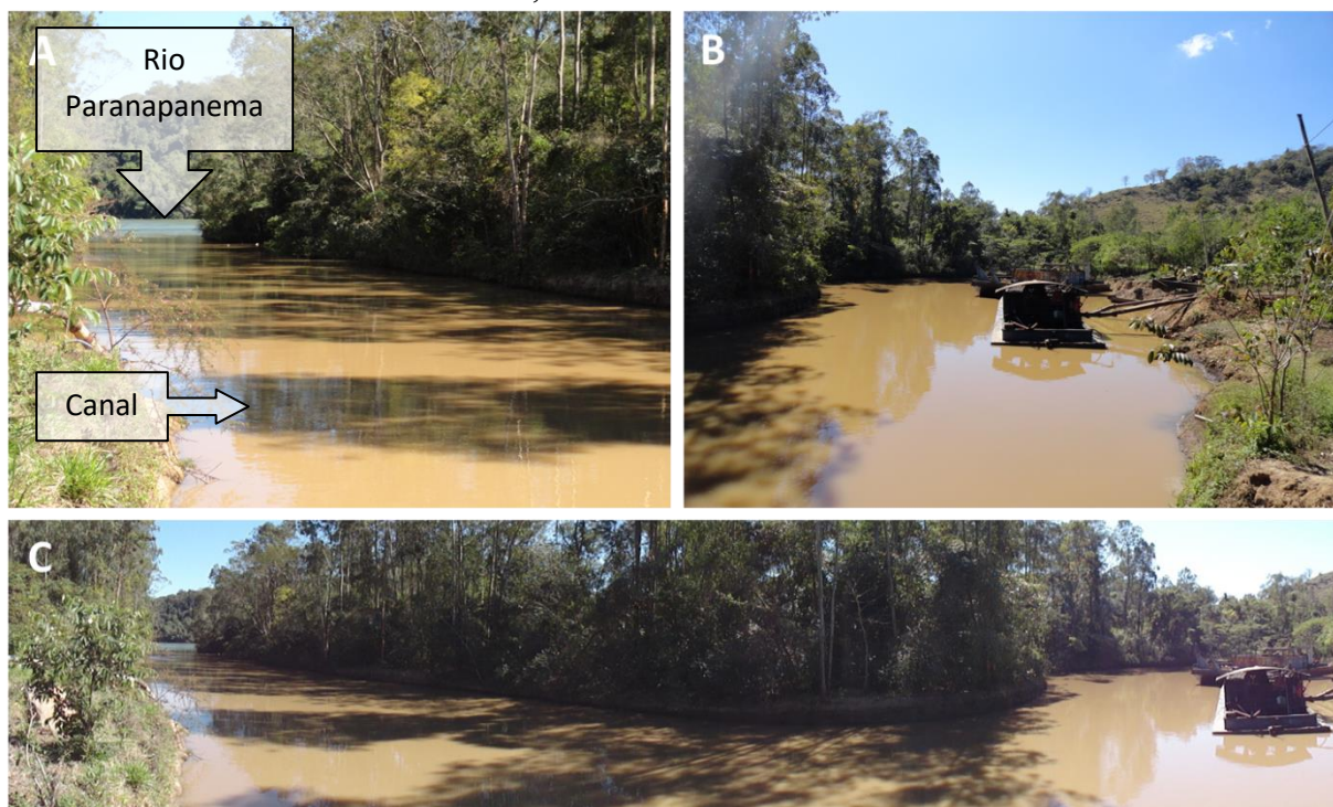
Figura 71. Canal feito na margem esquerda do rio Paranapanema para aportar a draga, Porto 2, Ribeirão Claro/PR.
